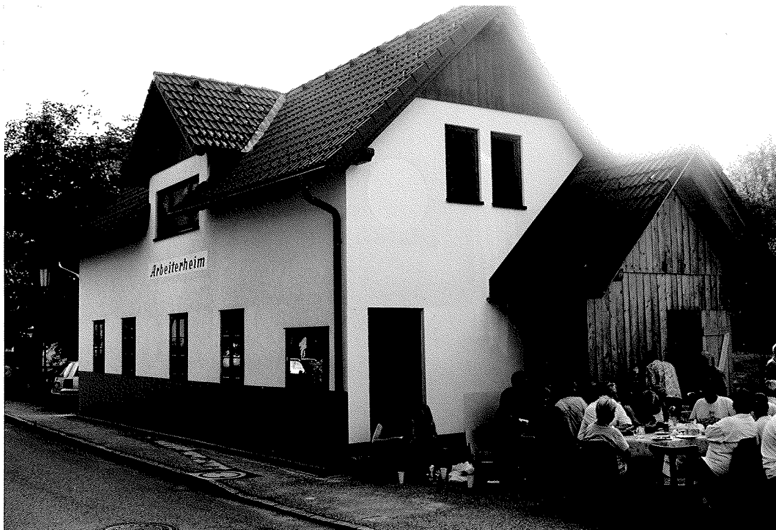
Abb. 11: Das Vereinsheim beeindruckt mit seiner neuen Fassade
